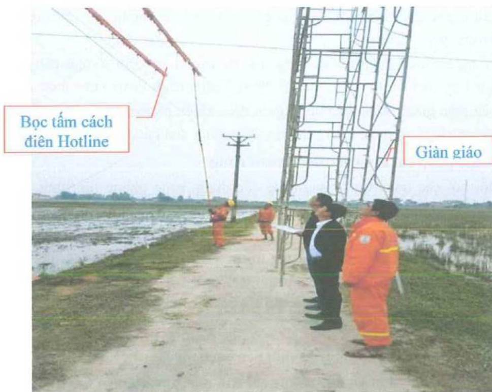
Hình 1. 7: Sơ đồ minh họa thi công vị trí vượt đường dây 0,4kV÷110kV không cắt điện
